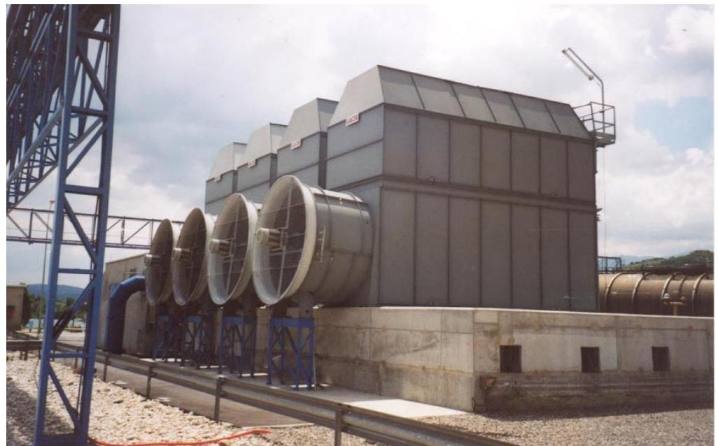
Wasserdurchsatz: von 70 bis 660 m<sup>3</sup>/ h pro Zelle
